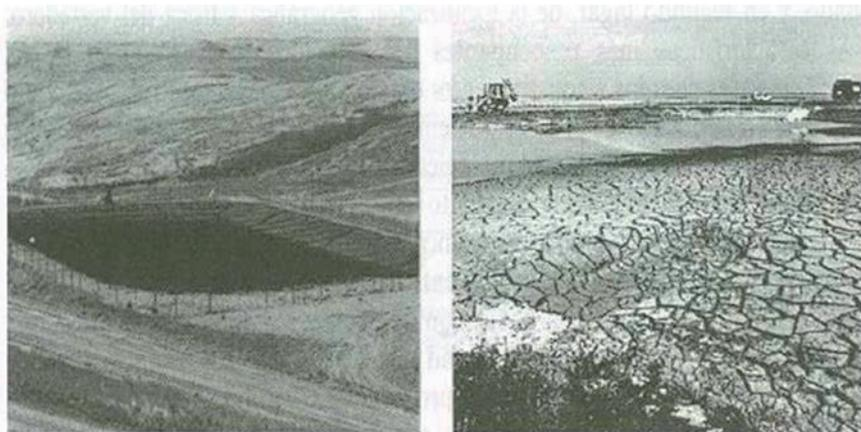
**Figura 3.** Piscinas antes y después del proceso de evaporización ambiental de lixiviados.
