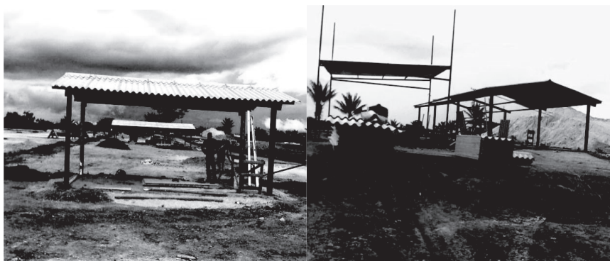
Figura. 5. Construcción de la Zona Veredal “Héctor Ramírez”. (24 de abril, 2018. Fotografía: Álvarez, D) (Puerto Gutierrez & Alvarez Molano, 2019, pág. 61).
