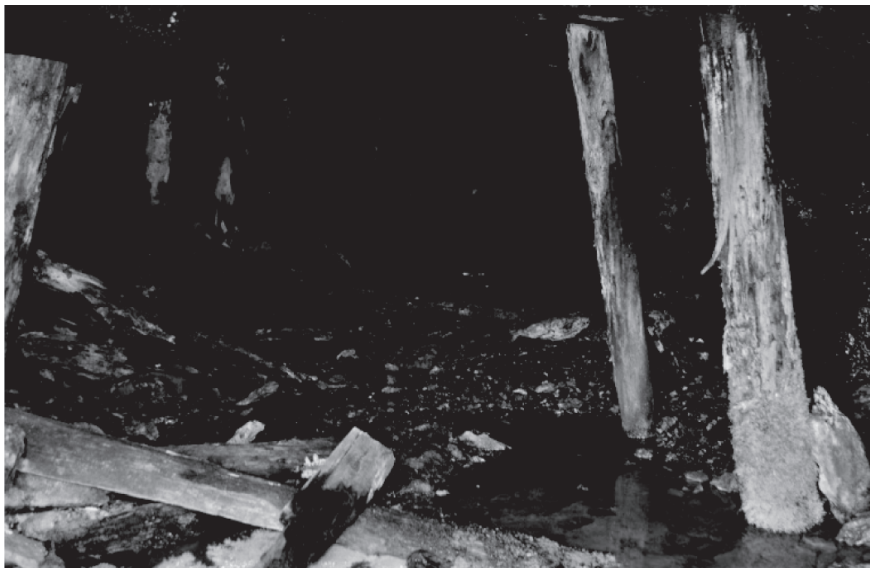
Fotografía No. 5. Interior del socavón abandonado
